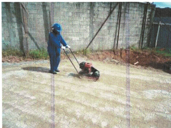
FOTO: 06,Compactação do PAVs
