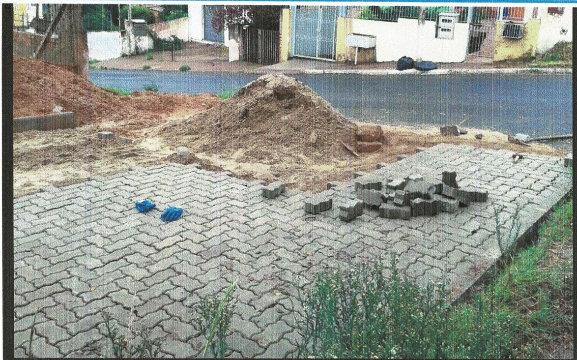
FOTO: 02, Foto do calçamento de rua urbana.
