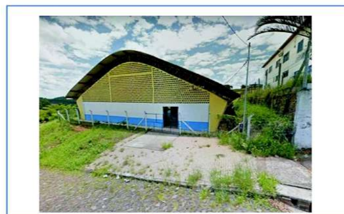
CARACTERÍSTICAS CONSTRUTIVAS DA QUADRA FECHADA COMPLEXO ESPORTIVO
