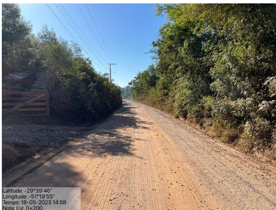
Foto 3: Vista geral do trecho - Estaca 0+200m
