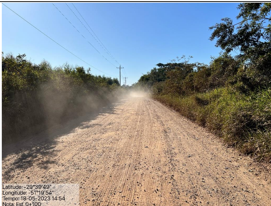
Foto 2: Vista geral do trecho - Estaca 0+100m
