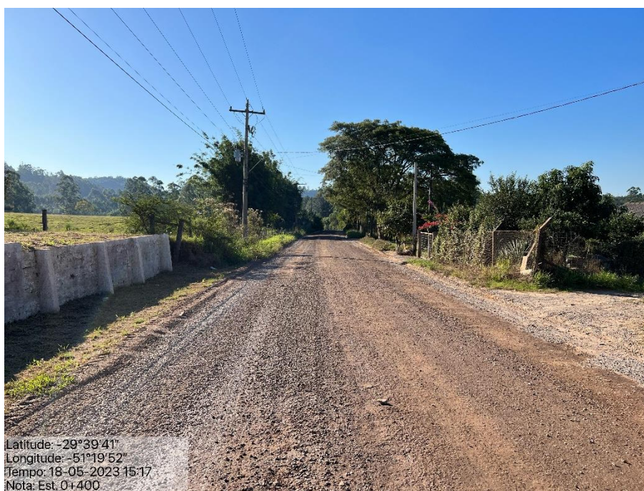
Foto 5: Vista geral do trecho - Estaca 0+400m
