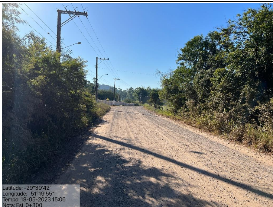
Foto 4: Vista geral do trecho - Estaca 0+300m
