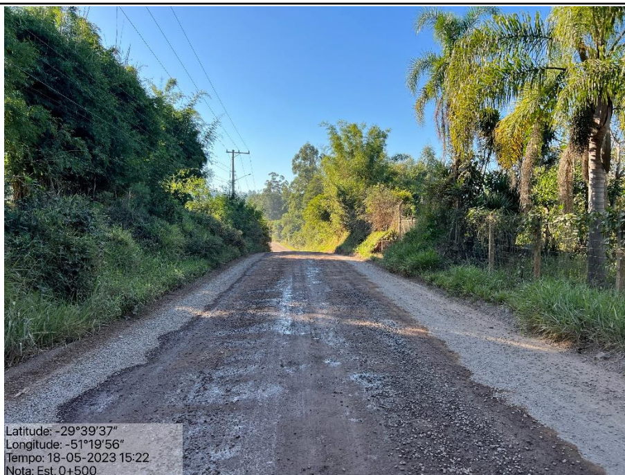
Foto 6: Vista geral do trecho – Estaca 0+500
