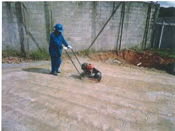
FOTO: 05, Compactação do PAVs
