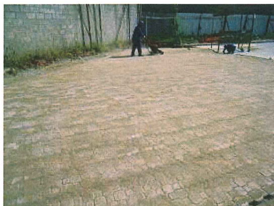
FOTO: 04, Salgamento com areia p/fixação e Compactação do PAVs
