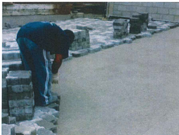
FOTO: 03, Assentamento dos PAVs.
