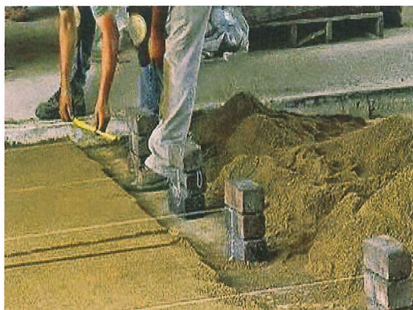
FOTO: 02, Colchão de Areia para assentamento PAVs.
